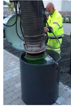
Figur 32 - Tømning af hævet sugestander
